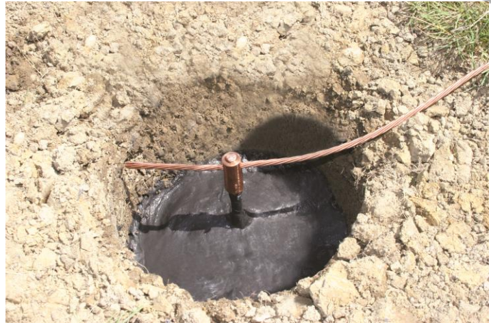
Exemple d'utilisation en mortier
